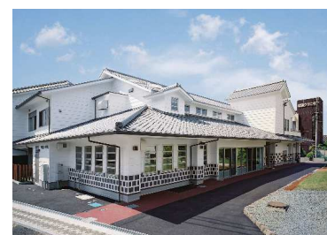
(社会福祉法人不動産会 特別養護老人ホーム わいふ桜座新築工事(熊本県))
