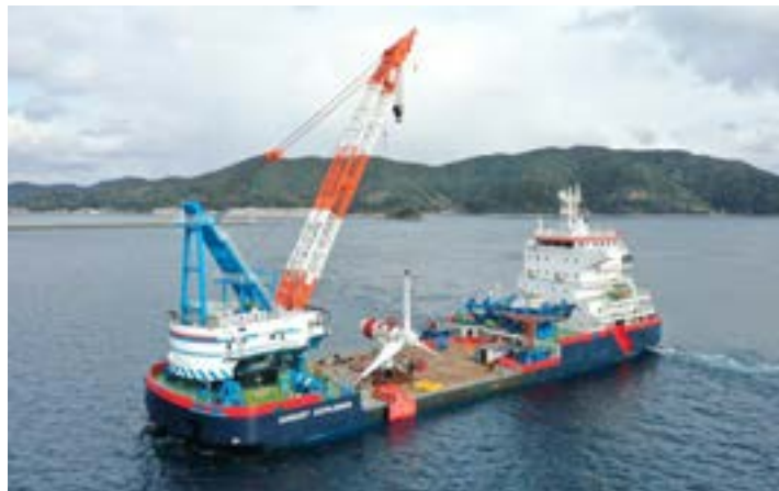
日本初の商用スケール大型潮流発電機の設置工事を五島列島「奈留瀬戸」で実施
