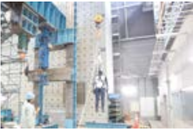
危険体感教育 (墜落制止用器具を用いた人形の墜落実験)
