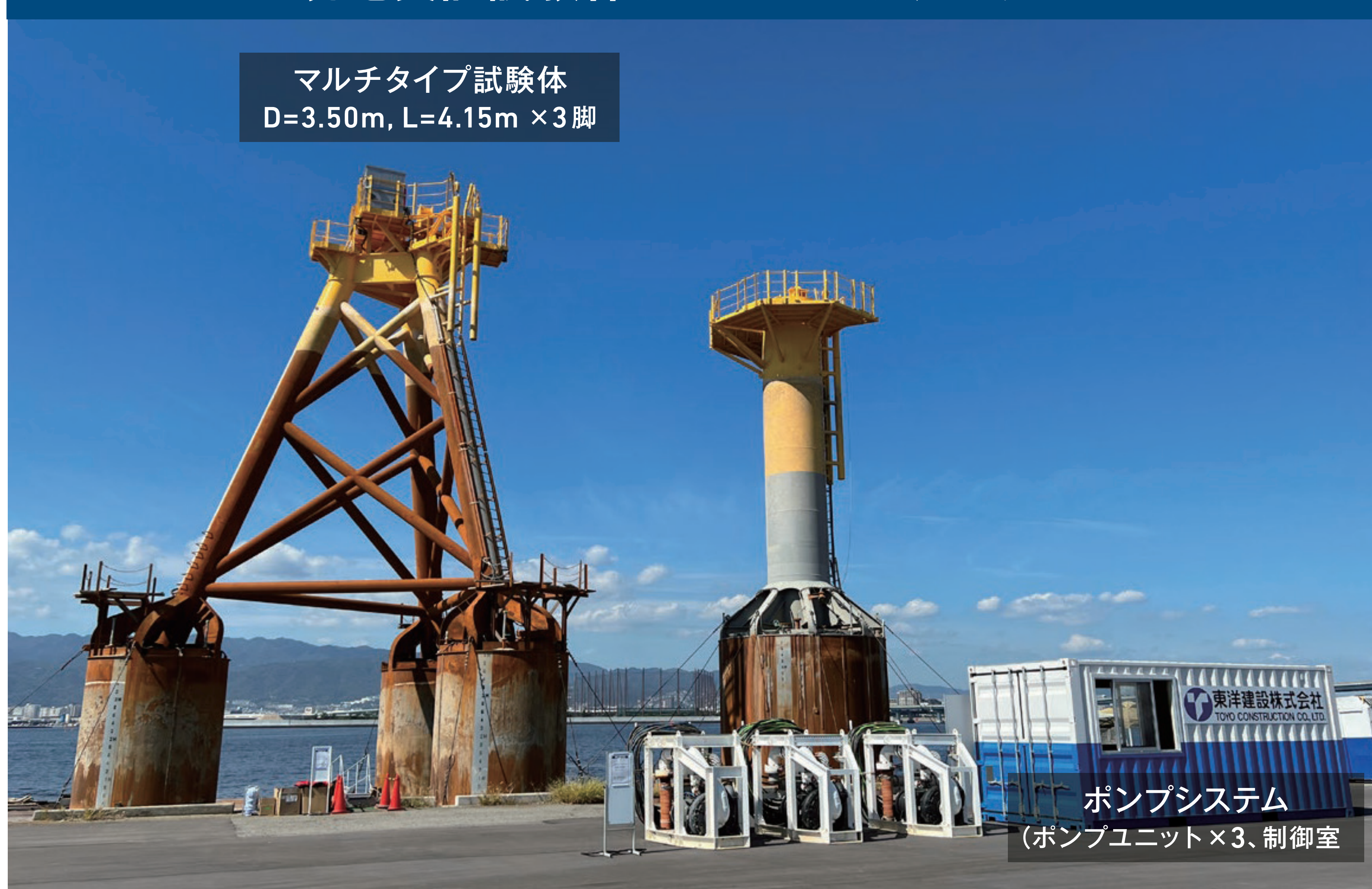
現地実証試験体およびポンプシステム
