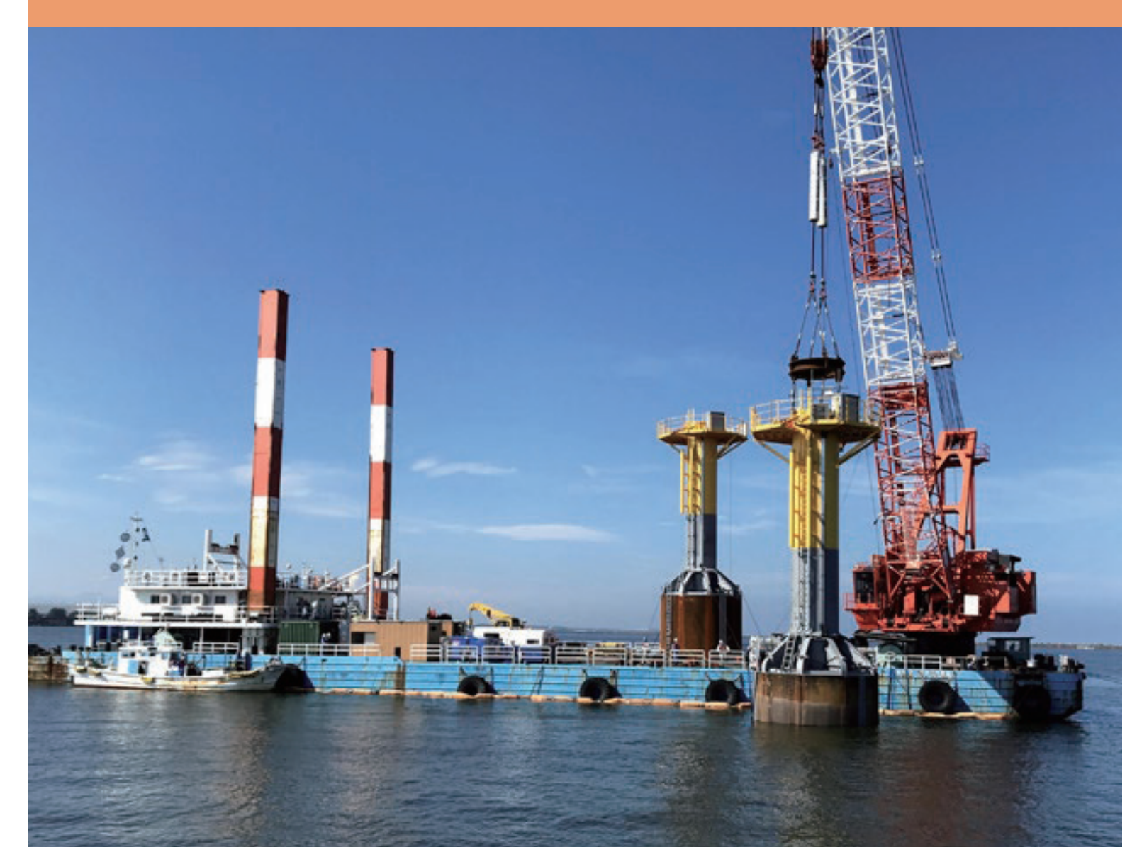
サクシヨンバケット施工状況
