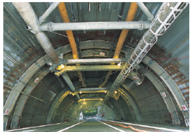
写真 - 3 仮締切内部
