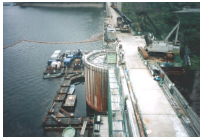
写真 - 1 仮締切施工状況
