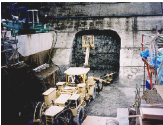
写真 - 4 堤体穴あけ状況
