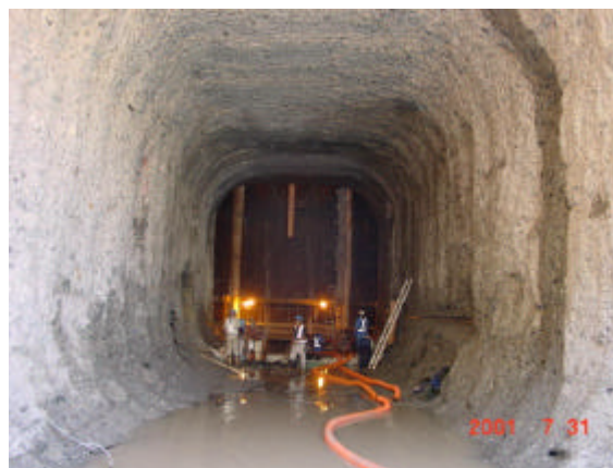
写真 - 5 堤体穴あけ全景
