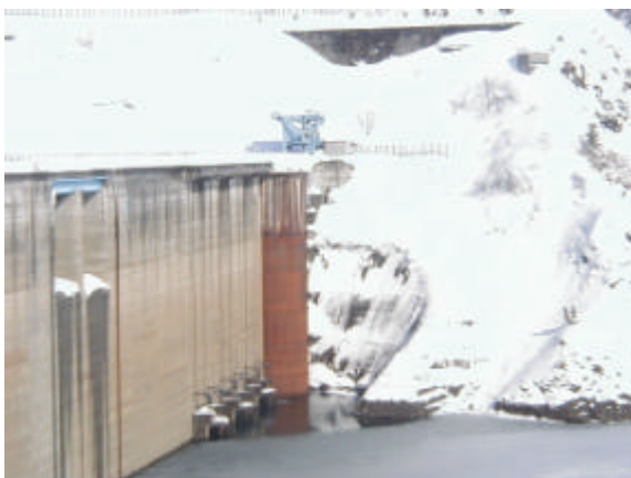
写真 - 2 仮締切完成状況
