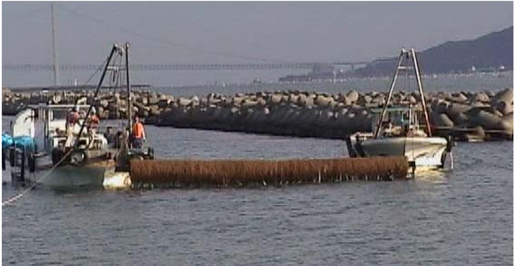
写真2 潜水士船を使った敷設状況
