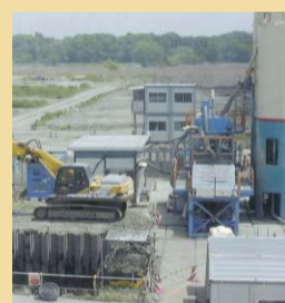
タフコン(解泥・固化処理)
