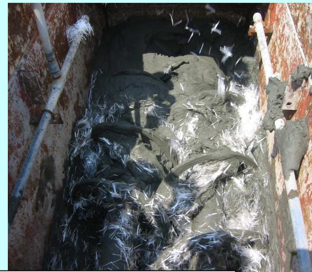
粘性土+固化材+繊維の混合攪拌状況
