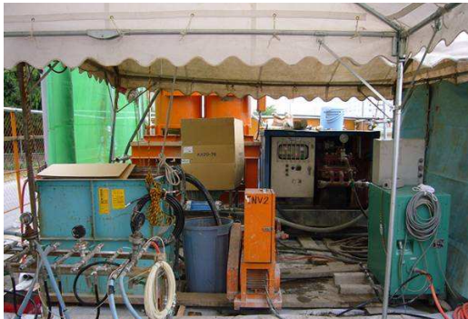
施工プラント
