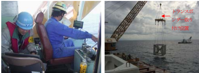
魚礁ブロック据付管理状況
