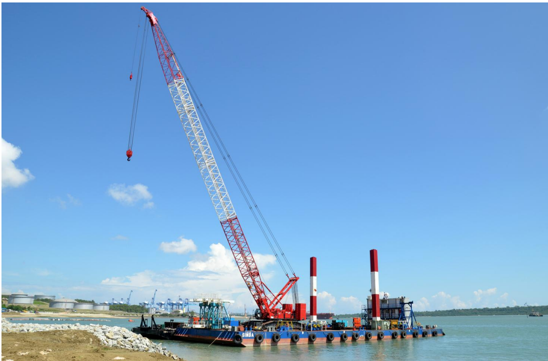
杭打船兼クレーン付台船 「TOYO SIMBA」
