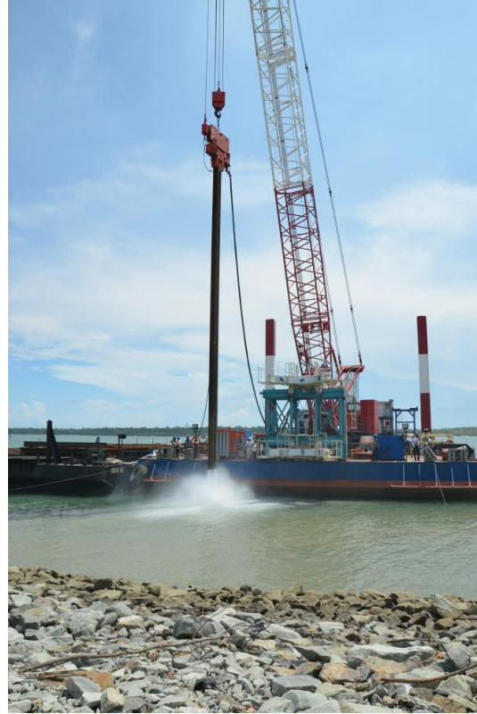
TOYO SIMBA 鋼管杭の打設初め
