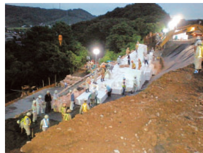
盛土工の様子
