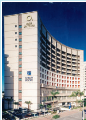
（仮称）「ロワジュールホテル 那覇スパアンドタワー」新築工事 （沖縄県）
