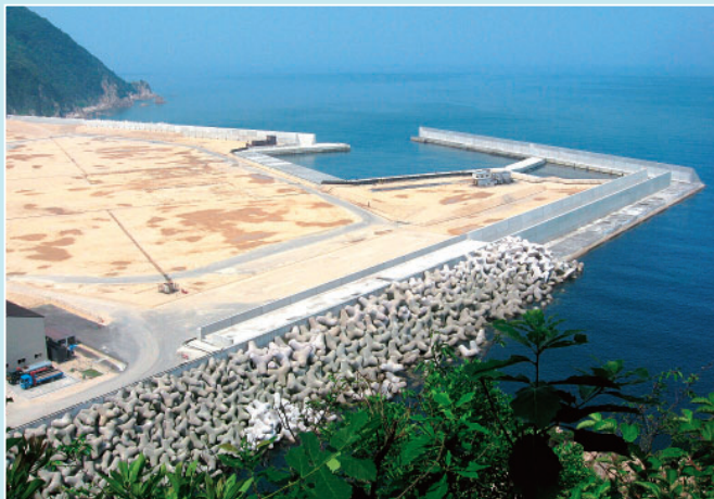
敦賀発電所3,4号機 防波堤・護岸設置他工事（防波堤・護岸設置工区）（福井県）
