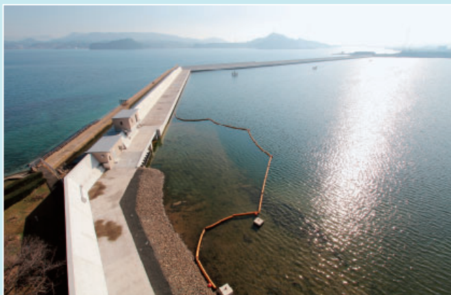
伊万里市第4工業用水道事業貯水施設建設工事（佐賀県）
