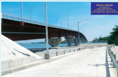
南部ルソン緊急橋梁P-3（フィリピン共和国）
