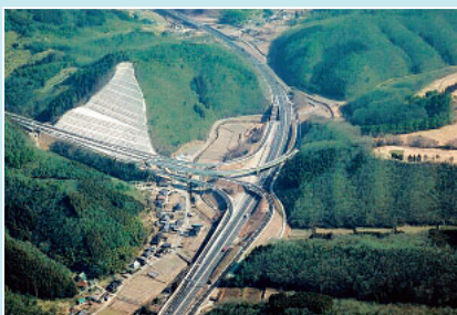
中国自動車道 口金近北工事（兵庫県）
