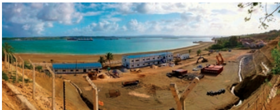
モンバサ港と現場事務所ヤード
