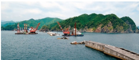
釜石港湾口防波堤における被災ケーソンの撤去
