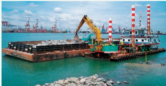
防波堤築造のための石材投入状況
