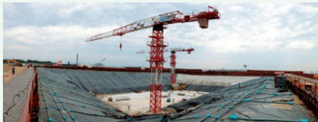
海水取水施設は、長さ53m、幅23m、地盤からの高さは16mにもなります
