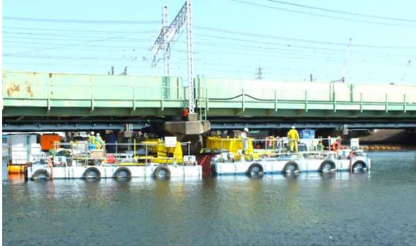
図-2 仮締切接合状況（桁下3m）
