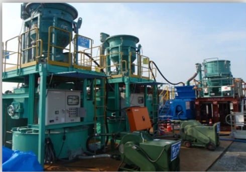
写真-2 プラント全景
