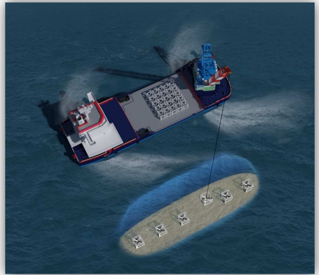
作業イメージ（深海域での魚礁設置）
