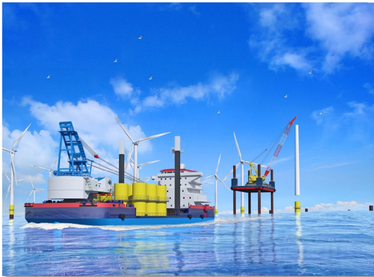
作業イメージ（洋上風力設置）
