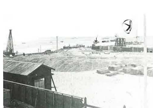
戦前の鳴尾工事現場の風景
