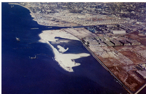
昭和46年当時の鳴尾埋立工事の様子
