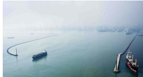
タンジュンプリオク緊急改修工事(インドネシア共和国)
