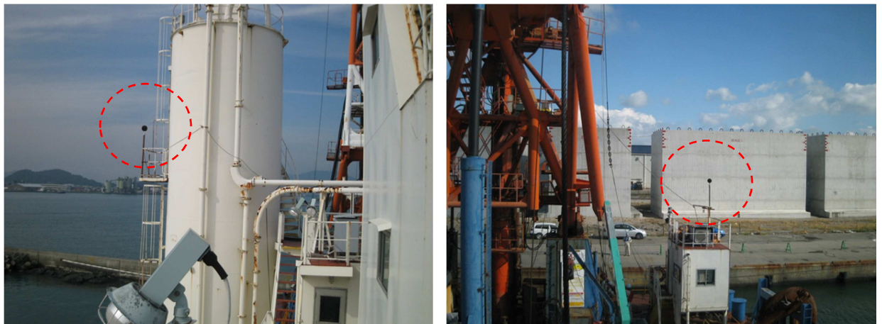
地盤改良工事騒音の監視（作業船にマイクを設置：赤破線内）
