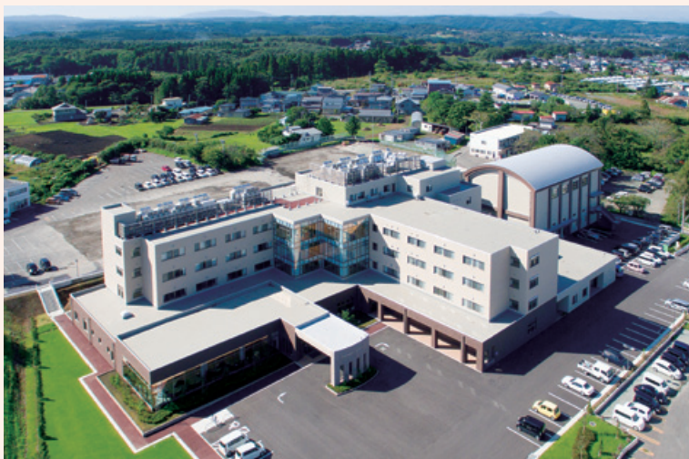
社会医療法人松平病院改築工事
