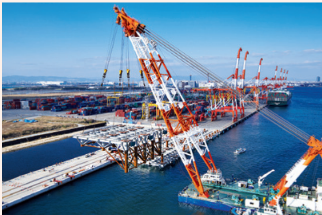
C-12コンテナヤードに大型起重機船でジャケットを据付けました
