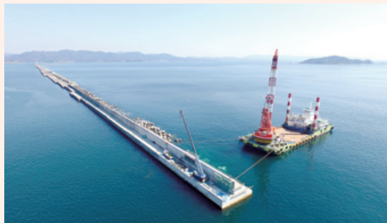
志布志港（若浜地区）防波堤（沖）築造工事
