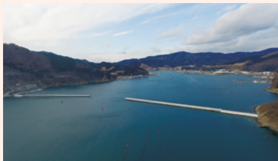
女川湾口防波堤災害復旧（その5）工事
