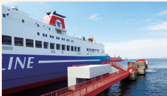
南港フェリー埠頭第一棧橋補強工事
