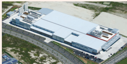
（仮称）株式会社武蔵野フーズカス神戸工場新築工事
