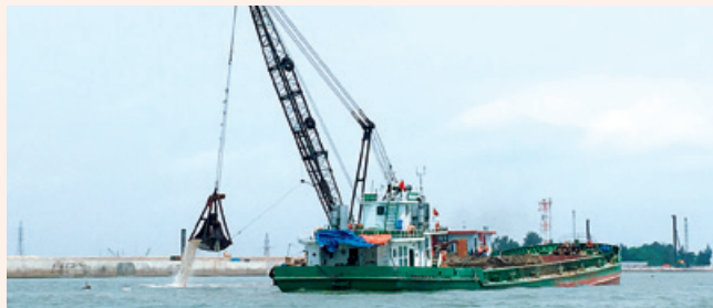
浚渫工事がいよいよ始まりました
