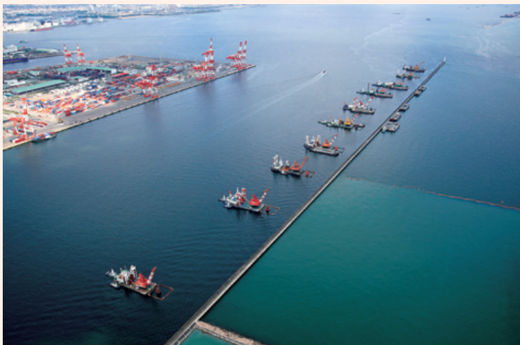
神戸港六甲アイランド地区航路・泊地（-16m）浚渫工事（二工区）
