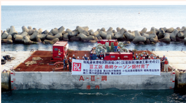
本港地区Ⅲ工区の最終ケーソンの据付けが無事完了しました
