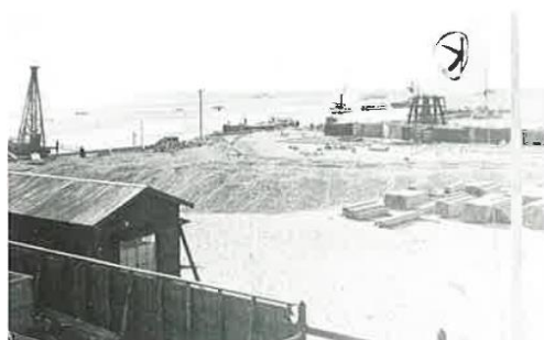
戦前の鳴尾工事現場の風景
