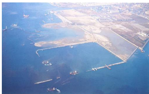
昭和46年当時の鳴尾埋立工事の様子
