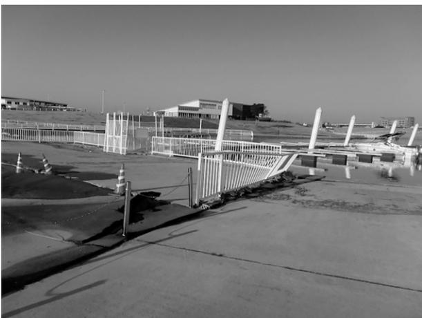
河川マリーナの震災被害（路面は波打ち、栈橋も倒壊）
