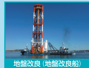
地盤改良 (地盤改良船)
