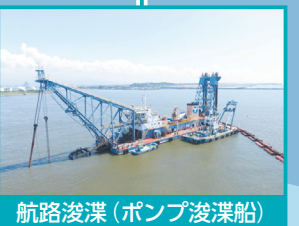
航路浚渫 (ポンプ浚渫船)
