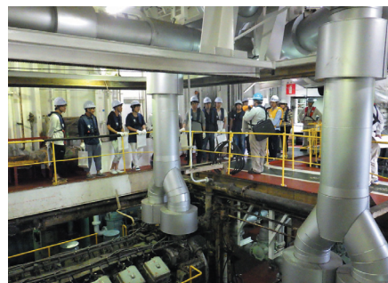
あまり目に触れることのないポンプ浚渫船の機関室
