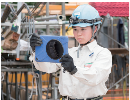
図面管理ソフトを搭載したタブレット端末で工事写真を撮影。「日々変化する工事現場の状況を記録し、設計通りに施工したことを証明する重要な作業です」(黒見)
