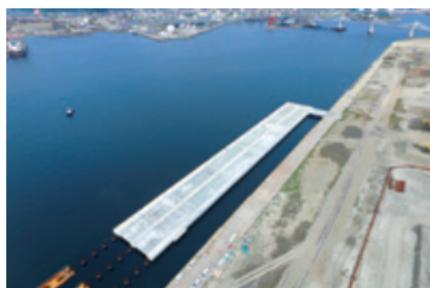
小名浜港東地区の施工状況。打設した鋼管杭の上にPCホロー桁を設置します。
