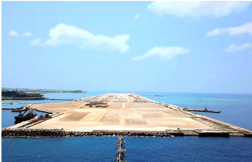
那覇空港滑走路増設4工区埋立工事（沖縄県）
