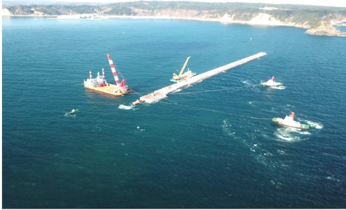
久慈港湾口地区防波堤（北堤）築造工事 （その2）（岩手都）
