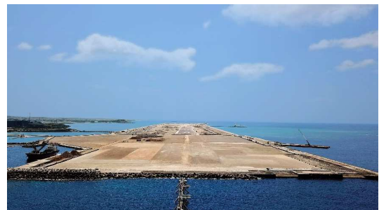
那覇空港滑走路増設4工区埋立工事 完成 工期：2016年12月～2018年3月 概要：埋立工、裏込・裏埋工、上部工 他
