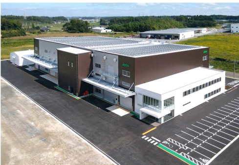
城東テクノ(株)茨城工場新築工事（茨城県）
