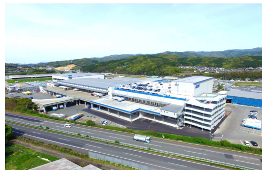
株式会社ランテック福岡支店増築工事（福岡県）
