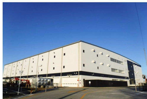
（仮称）蓮田ロジスティクスセンター新築工事（埼玉県）
