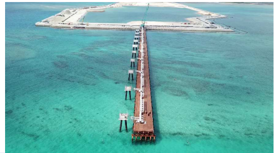
那覇空港滑走路増設南側進入灯橋梁工事（南進入灯） 施工中 工期：2016年6月～2019年3月 概要：橋梁下部工、橋梁上部工（工場製作工、鋼橋架設工）他
