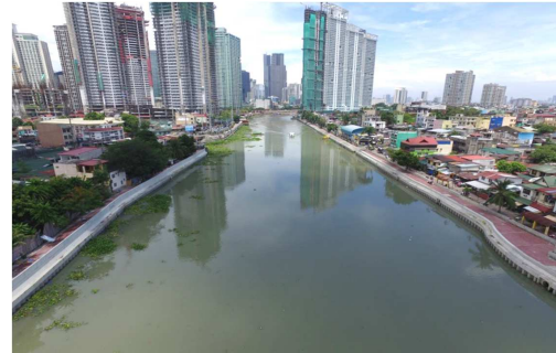
パシグ・マリキナ河川改修Phase3（円借） （パシグ工区）（フィリピン共和国）
