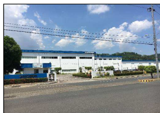
山洋電機フィリピン第3工場新築工事
