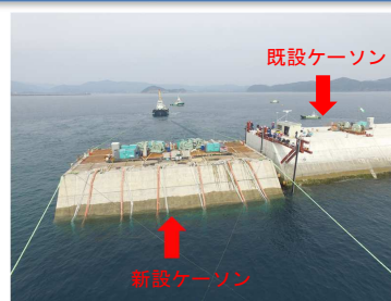
自動制御による据付状況
