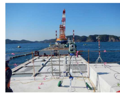
既設側から自動追尾計測
