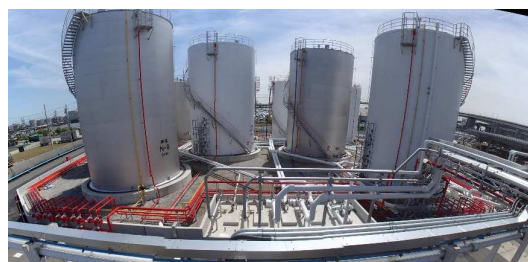
名古屋事業所新設タンク設置（※設計施工） 発注者：セントラル・タンクターミナル(株) 様
