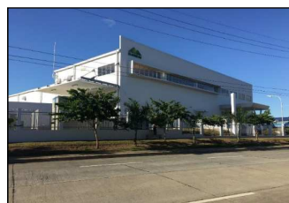
バンダイワイヤーハーネス フィリピン工場新築工事
