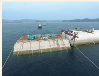
ケーソンの据付において、注水・ウインチ操作の自動制御を実現。従来は動揺するケーソン上に人が乗って測量をしていましたが、無人化とすることにより省人化、効率化と合わせて、安全性が飛躍的に向上しました。
