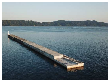
宿毛湾港池島地区防波堤(Ⅱ)築造工事 (高知県)
