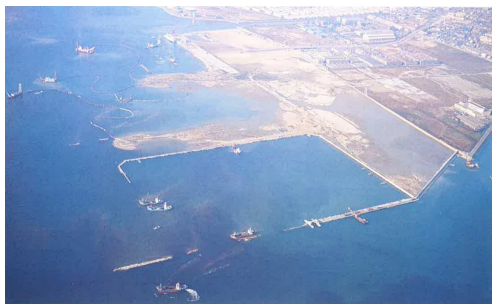
昭和46年当時の鳴尾埋立工事の様子
