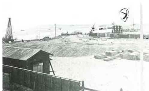
戦前の鳴尾工事現場の風景
