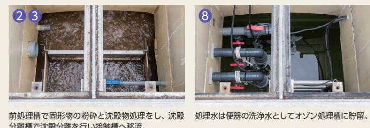
前処理槽で固形物の粉碎と沈殿物処理をし、沈殿分離槽で沈殿分離を行い接触槽へ移流。処理水は便器の洗浄水としてオゾン処理槽に貯留。
