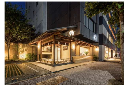
松栄堂薫習館改装工事(京都市)
