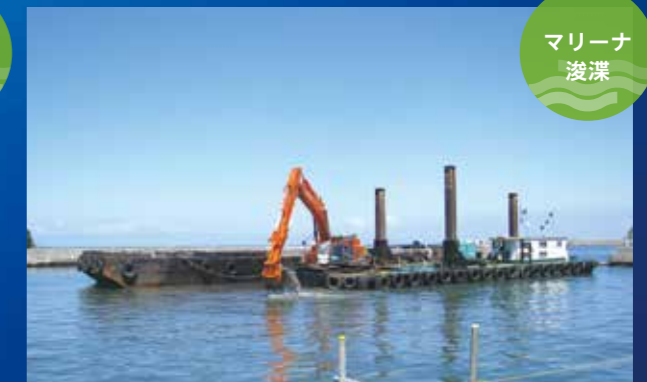
係船設備維持浚渫
