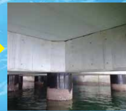
補修後 コンクリート断面修復
