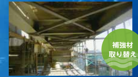
補強材欠損
