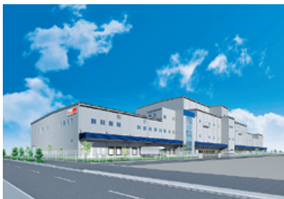
エスフーズ株式会社様 新船橋工場
