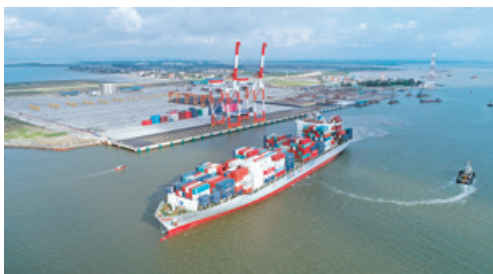
完成したラックフェン港
