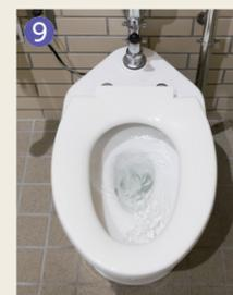
オゾン処理槽の処理水は給水ポンプで便器の洗浄水として循環再利用。無色透明で衛生性も高い洗浄水です。
