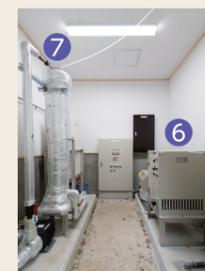
オゾン発生器でオゾンガスを精製し、反応塔で処理水とオゾンガスを接触、反応させ脱色、脱臭、殺菌処理を行います。
