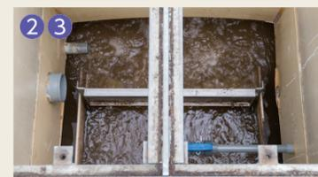
前処理槽で固形物の粉碎と沈殿物処理をし、沈殿分離槽で沈殿分離を行い接触槽へ移流。
