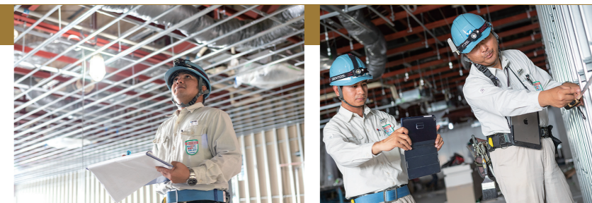
電気エンジニアとして、現場の電気系統の記録を確認するアレンさん 東洋建設の日本人職員とともに現場の品質管理に努めるアレックスさん(左)
