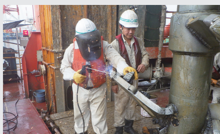
地盤改良船上での日本人指導員による溶接指導
