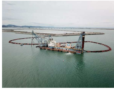
平成30年度苅田港(新松山地区)泊地(-13m)浚渫工事(福岡県)
