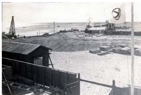
戦前の鳴尾工事現場の風景
