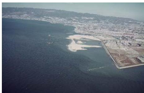
昭和46年当時の鳴尾埋立工事の様子
