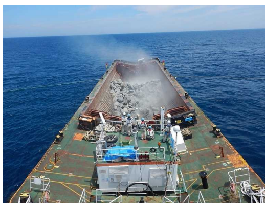
平成31年度対馬海峡地区マウンド礁築造工事（長崎県）
