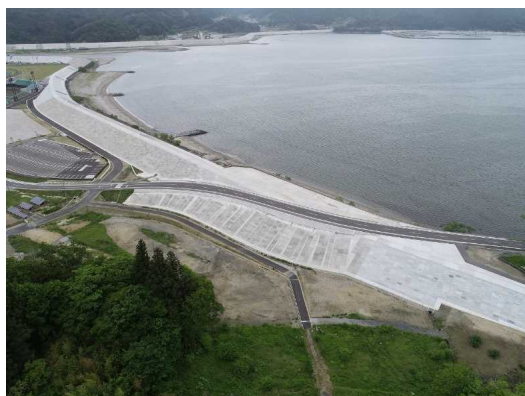
赤前地先海岸災害復旧（23災456号）その3工事（岩手県）
