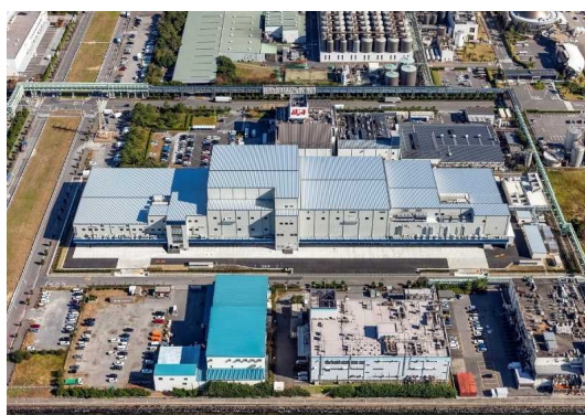
（仮称）エスフーズ㈱新船橋工場新築工事（千葉県）
