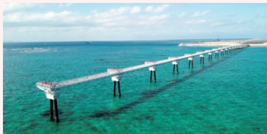
那覇空港滑走路増設南側進入灯橋梁工事
