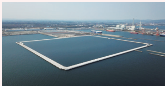
茨城港常陸那珂港区中央ふ頭地区廃棄物埋立護岸築造工事（その2）
