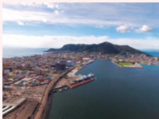
当社が主体となって設計施工で完成した 大型クルーズ船岸壁
