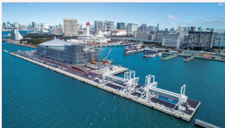
13号地新客船ふ頭岸壁（29）建設工事
