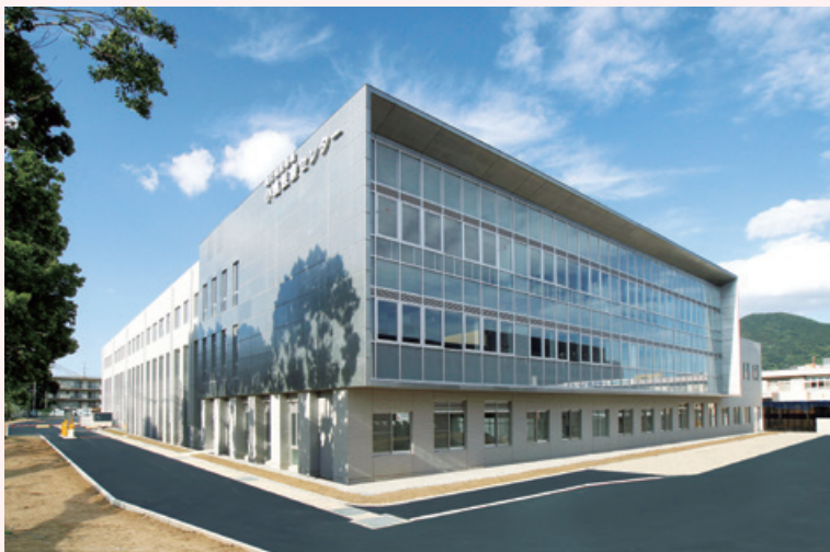
独立行政法人国立病院機構小倉医療センター 外来管理診療棟建替整備工事（建築Ⅰ期・解体Ⅰ期）
