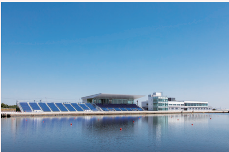
平成27年度海の森水上競技場整備工事
