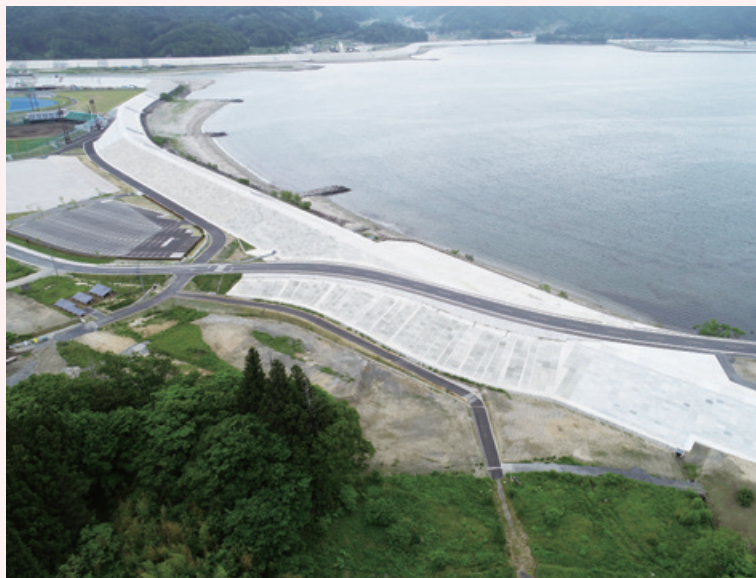
赤前地先海岸災害復旧（23災456号）その3工事
