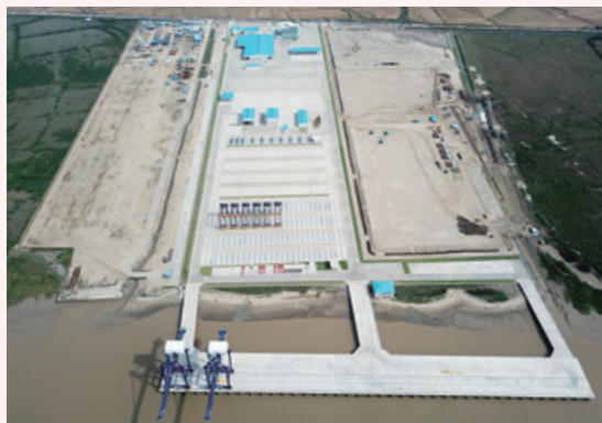
ティラワ港開発工事
