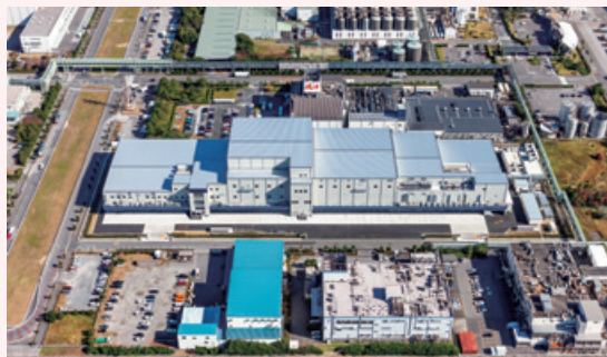
（仮称）エスフーズ株式会社新船橋工場新築工事
