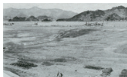
佐伯航空隊敷地埋立工事(大分県)
