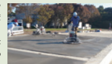
床スラブひび割れ対策実験（施工中）
