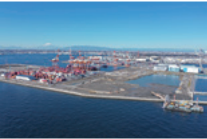
南本牧埋立土砂海上運搬及び揚土工事
