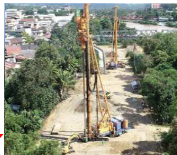
施工状況（静的締固工）
