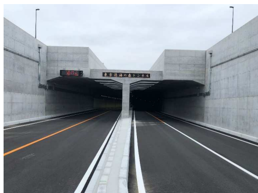
東京港臨港道路南北線沈埋函(4号函・5号函・ 6号函)製作・築造等工事（東京都）
