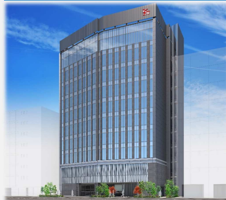
(仮称)フレンドビル建替計画
