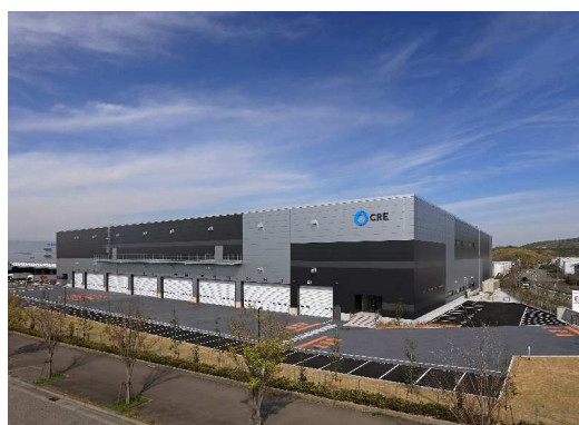
ロジスクエア神戸西新築工事（兵庫県）
