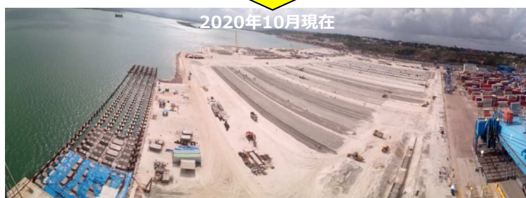
コンテナヤード 舗装工全景
