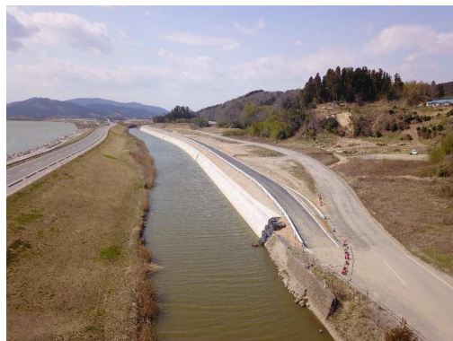
平成28年度県債311地震災5020-004号 大沢川河川災害復旧工事(その4)（宮城県）
