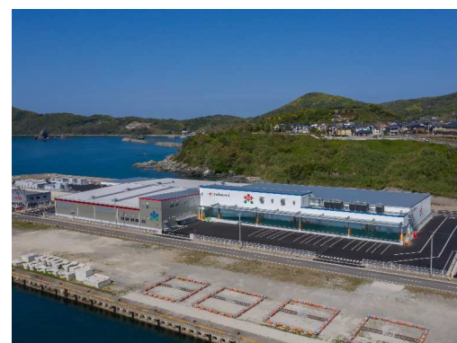
(仮称)横浜冷凍株式会社 長崎ソーティングスポット 新築工事（長崎県）
