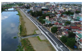
フェーズIII 完成（当社施工）
