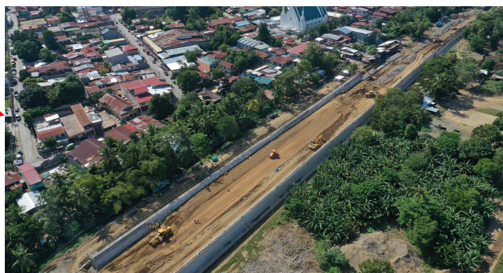
施工状況（路体工、路床工、擁壁工）
