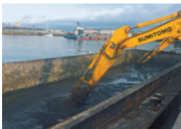
浚渫土とカルシア改質材の混合
