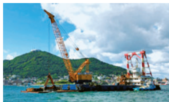
函館港若松地区泊地浚渫の施工状況
