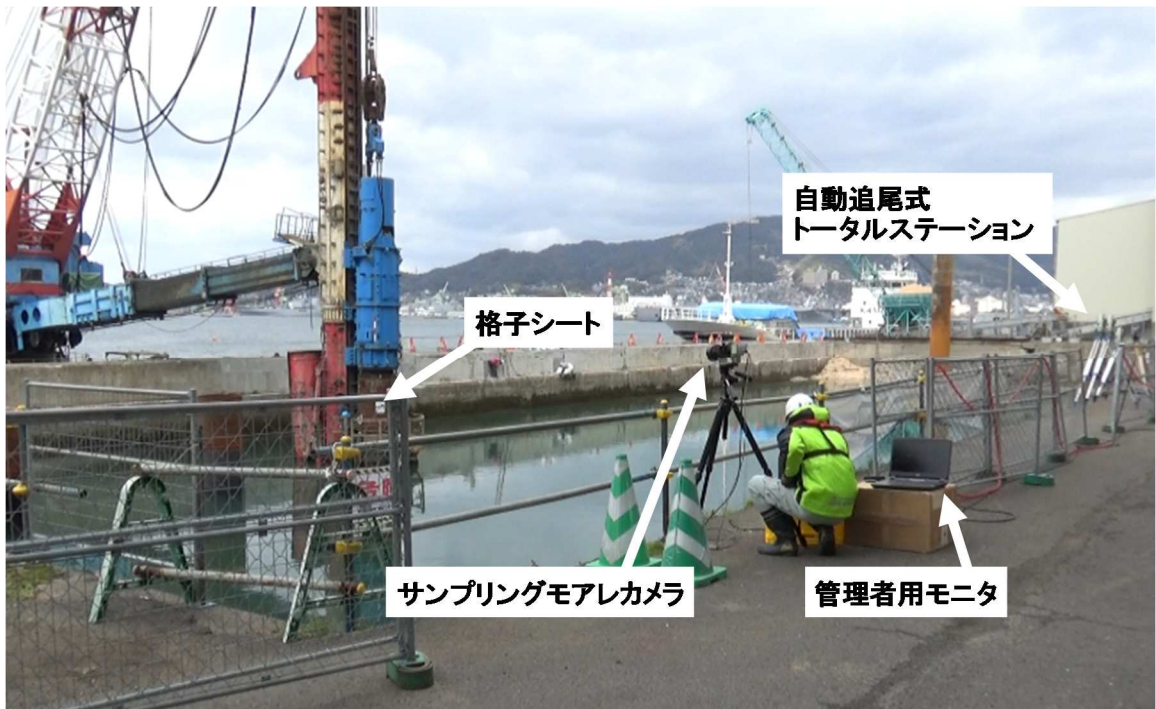
打設杭トータル施工管理システムの現場導入状況
