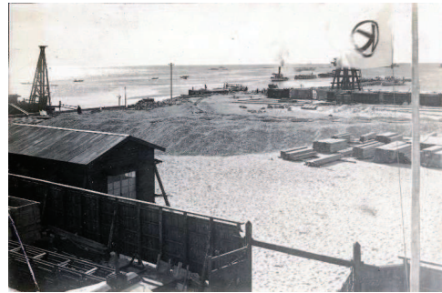
戦前の鳴尾工事現場の風景
