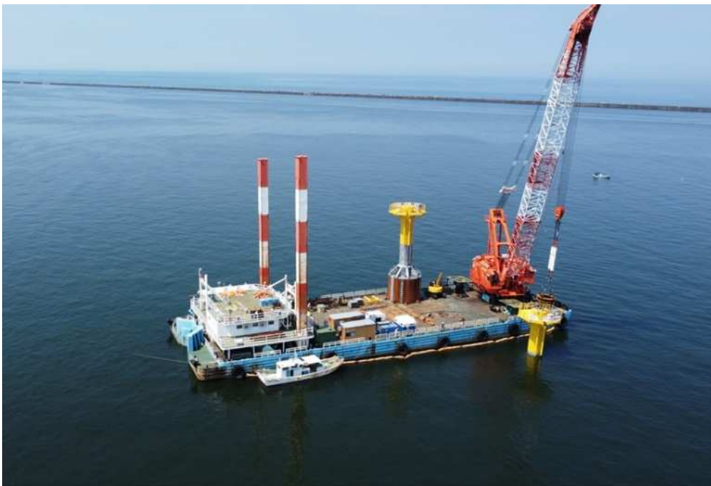
実証試験の状況
