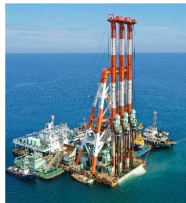
図-2 石狩湾新港での SCP 打設状況
