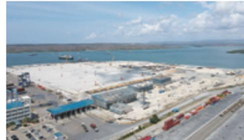
当社が1期工事に続いて建設に携わっているケニア共和国モンバサ港コンテナターミナルは、東アフリカ最大の商業港で、周辺内陸国を結ぶ「北部回廊」の玄関口として重要な役割を担っています。2期工事においては、栈橋の上部工や建築施設にプレキャスト工法を積極的に活用し、工期短縮を図ることで、1日も早い完成を目指しています。
