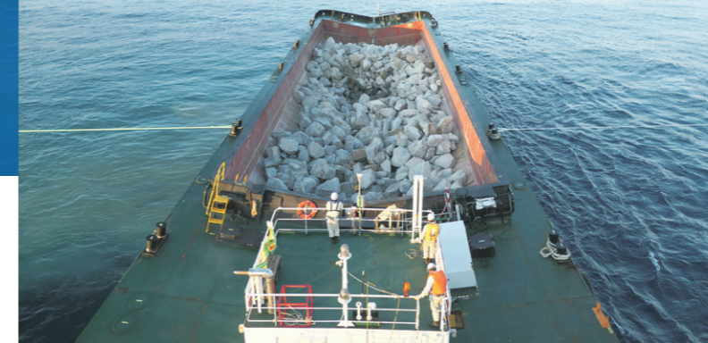
石材を海底に投入する専用船。写真上部の船底が開いて、石材を投入する
