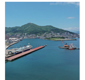
函館港若松地区岸壁工事・泊地浚渫工事(北海道)
