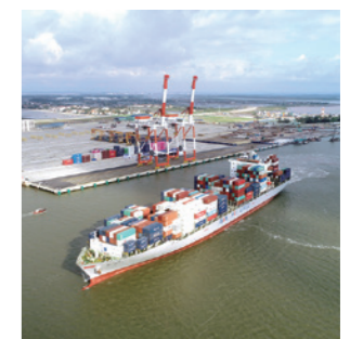
ラックフェン港航路浚渫工事(ベトナム)
