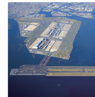
東京国際空港D滑走路建設外工事(東京都)
