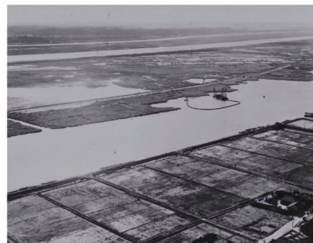
利根川浚渫工事
