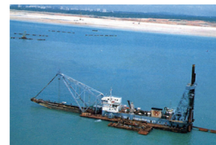
チャンギ埋立工事(シンガポール)
