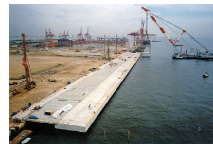
六甲アイランド緊急岸壁復旧工事(兵庫県)
